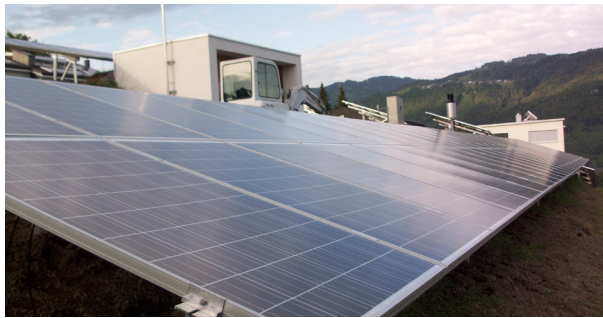
Die Gemeinschaftsanlage Pofel in vollem Glanz
